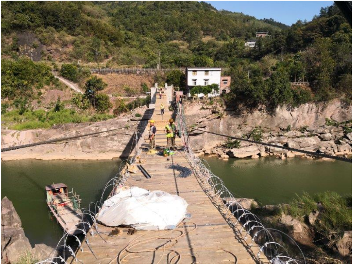
盖石铁索桥建设中照片
