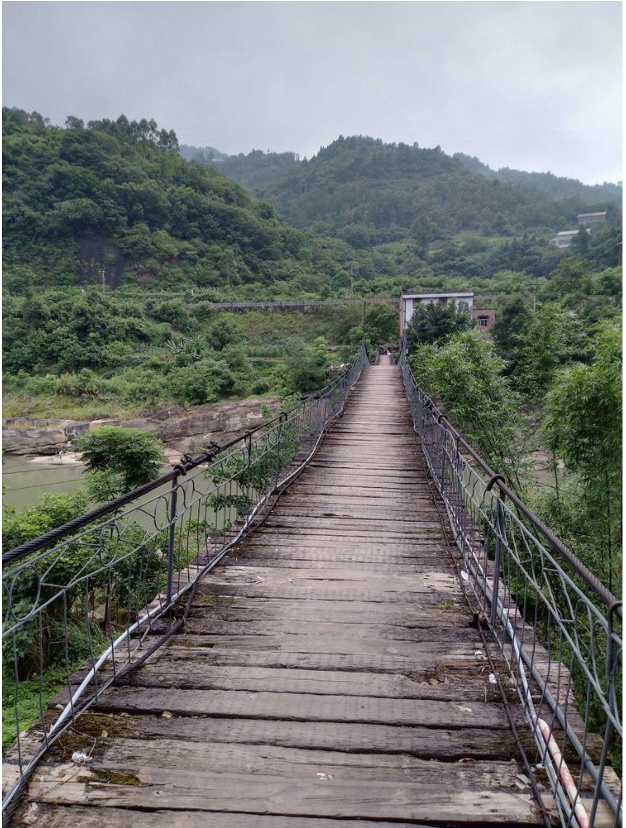
篆塘镇盖石铁索桥原貌及冲毁后
